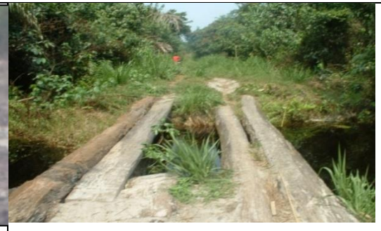
Photo n°11 : Vue d'un pont en bois sur la piste dans la Cuvette-Ouest
