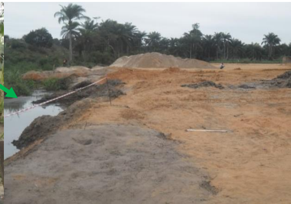
Photo 2 : un site maraîcher remblayé à Ngoyo pour la construction des entrepôts de la Société Libanaise MBTP.
