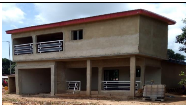
Photo 4 : Une villa-duplex en construction (Cliché Konan, 2017)
