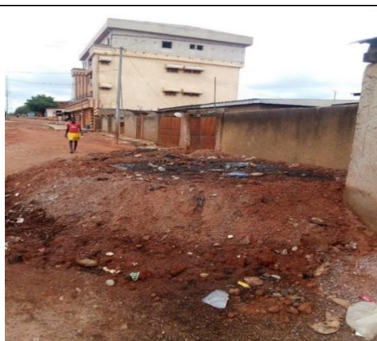
Photo 3 : une fosse de vidange aménagée à Huberson
