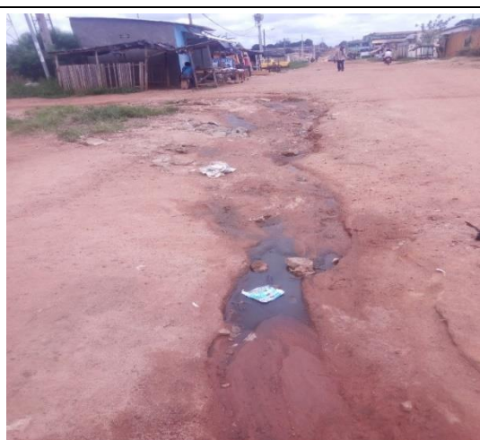
Photo 2 : Reste des boues déversées dans la rue, lors de pluie à Lobia (Prises de vues : A. GOUAMENE, 2019).
