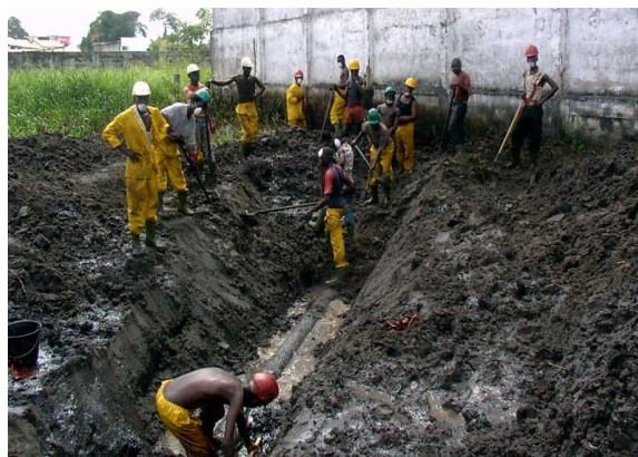
Photo 5 : Travaux de fouille du pipeline percé
