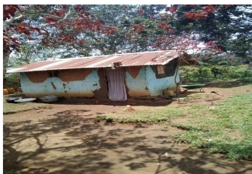
Photo 1 : habitation avec des murs en pisé et un toit en tôles à Matoto (département de la Lékoumou). Les murs sont crépis et peints
