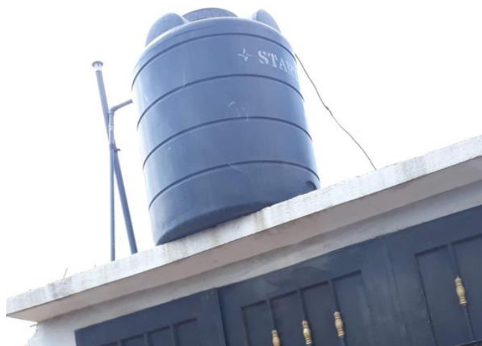
Photo n°3 : Un super tank installé sur une dalle à Dévégo
