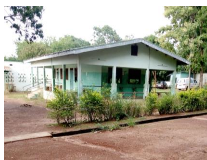
Photo 3 : Bâtiment du centre de santé de Torgokaha
