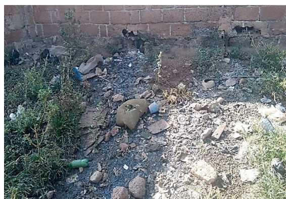
Photo 2 : Déversoir d'eaux usées derrière une cour à Koko
