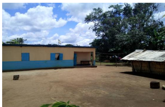
Photo 2 : au premier plan, à droite, une case avec un mur en pisé et un toit en tôles ; en arrière-plan, une habitation avec des murs en briques adobes et un toit en tôles à Tsomono (département de la Bouenza). Les briques sont couvertes d'enduits en ciment.
